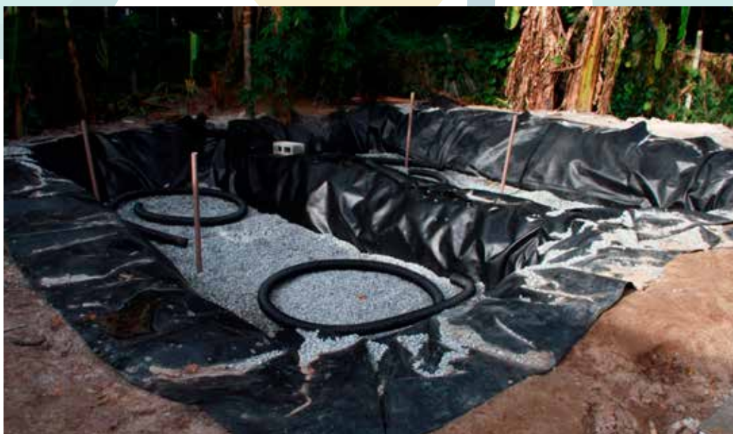
Figura 3: Tanque de Evapotranspiração (TEVAP) em construção em Encantadas (Ilha do Mel/PR)
