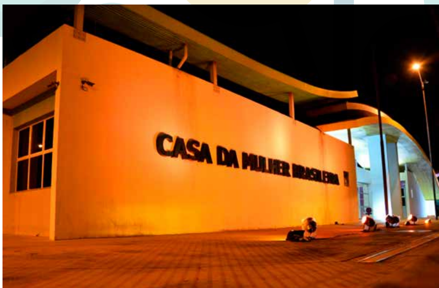
Figura 2: Casa da Mulher Brasileira, local de apoio para mulheres que sofrem de violência doméstica
